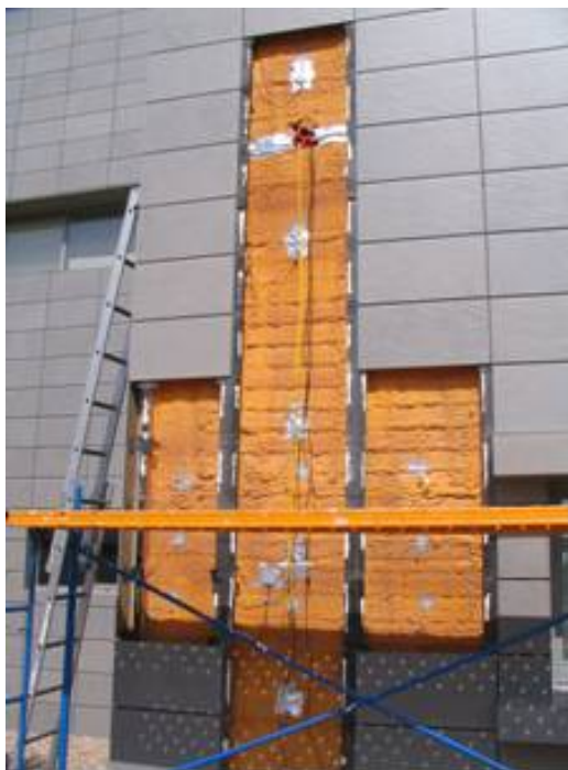
Figura 7.3. Detalle del proceso de montaje de sensores en fachada ventilada.
