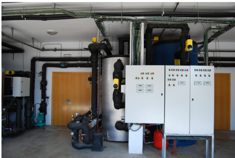
Fig. 4.3.9. Sistema de acumulación de agua fría.
