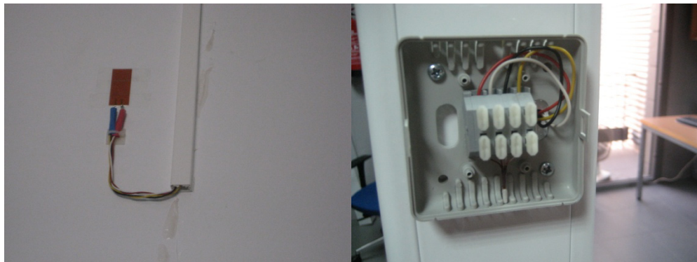
Fig. 4.3.19. Temperatura de superficie y sensor de tipo pt100.
