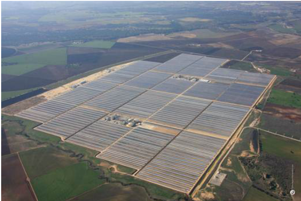
Fig. 2.4.6.1 Vista aérea de las plantas Valle 1 y Valle 2, ubicadas en San José del Valle, Cádiz (fuente Torresol Energy Investments, S.A).
