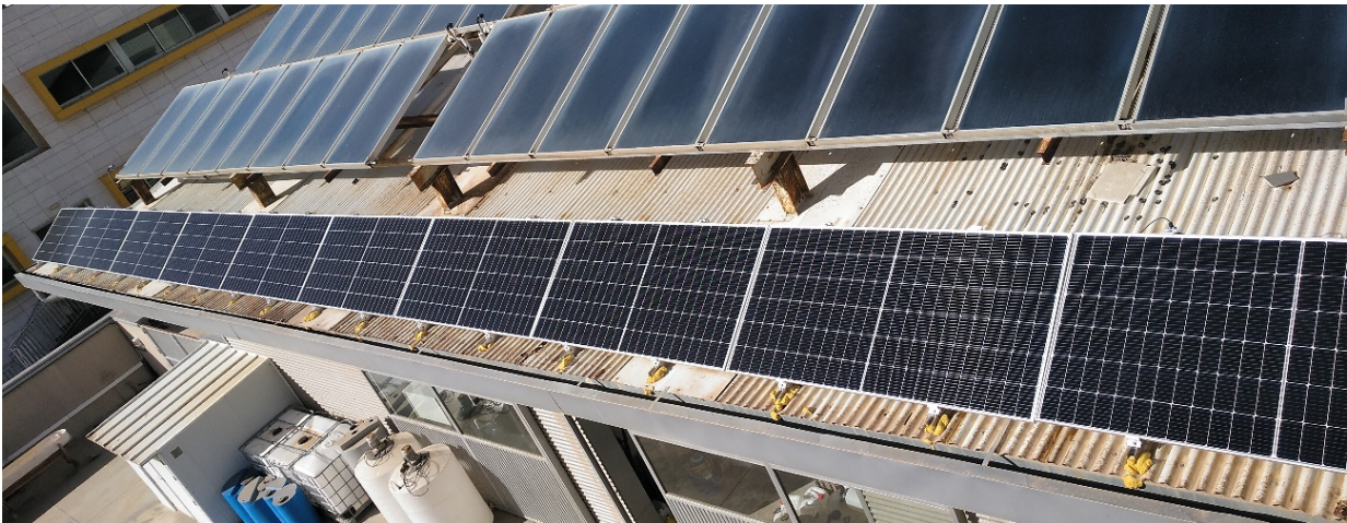
Nuevos módulos fotovoltaicos para el Smart-grid de CIESOL
