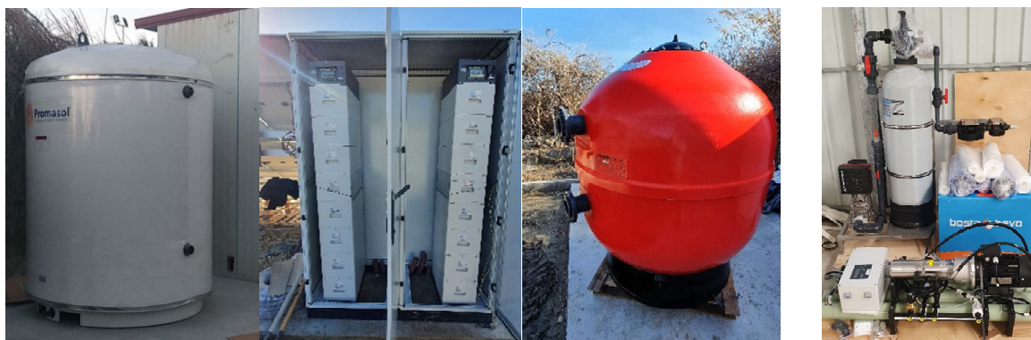
Depósitos de almacenamiento térmico, eléctrico y de CO2
