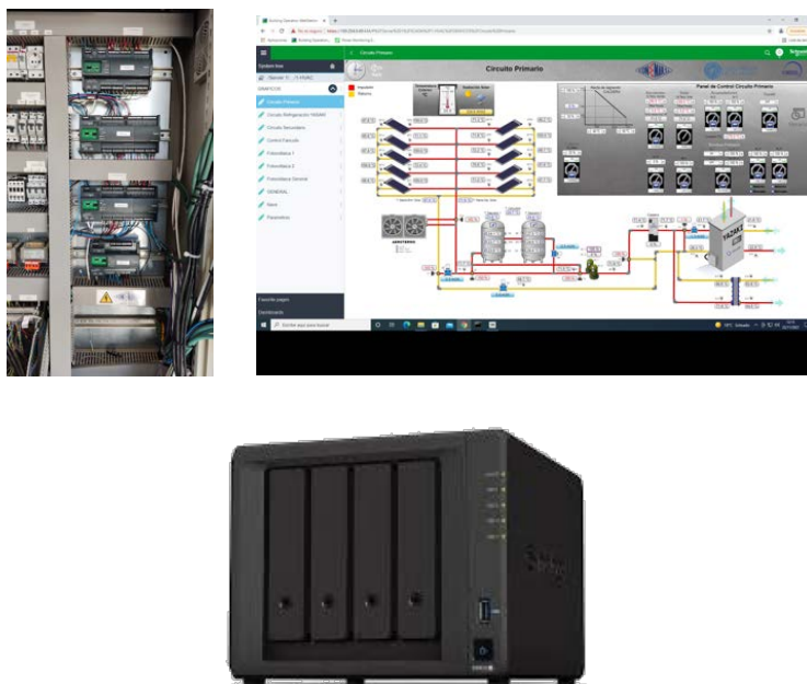
PLCs de Schneider Electric. Nueva aplicación de adquisición y servidor donde almacenar los datos.
