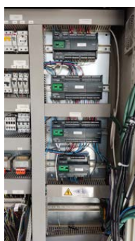
PLCs de Schneider Electric. Nueva aplicación de adquisición y servidor donde almacenar los datos.
