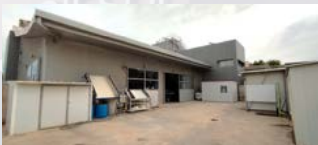
ESPACIO DE ENSAYOS CIESOL – Instalaciones para experimentación con aguas
