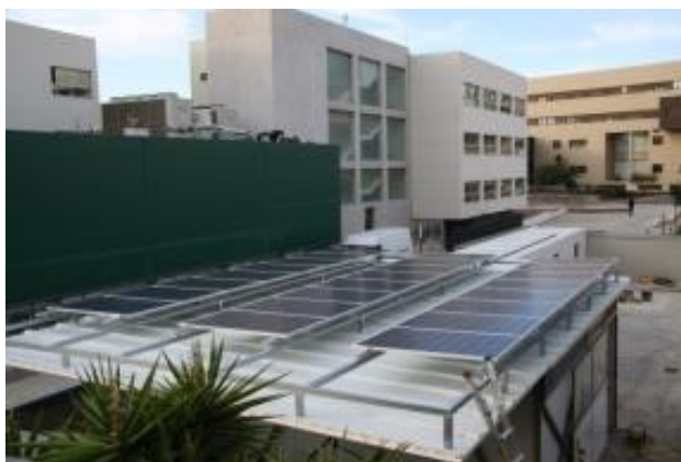
Fig. 3.2.2. Sistema híbrido que consiste en un areogenerador (izquierda) y un sistema fotovoltaico (derecha) instalado enfrente de la entrada principal del edificio CIESOL y en su patio, respectivamente, siendo la parte integral del proyecto UNAM13-1E-2532.
