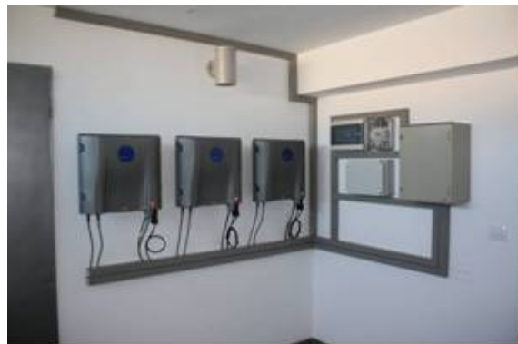
Figura 7.3. (a) Planta fotovoltaica instalada en CIESOL, (b) Inversores de la planta fotovoltaica instalada en CIESOL.
